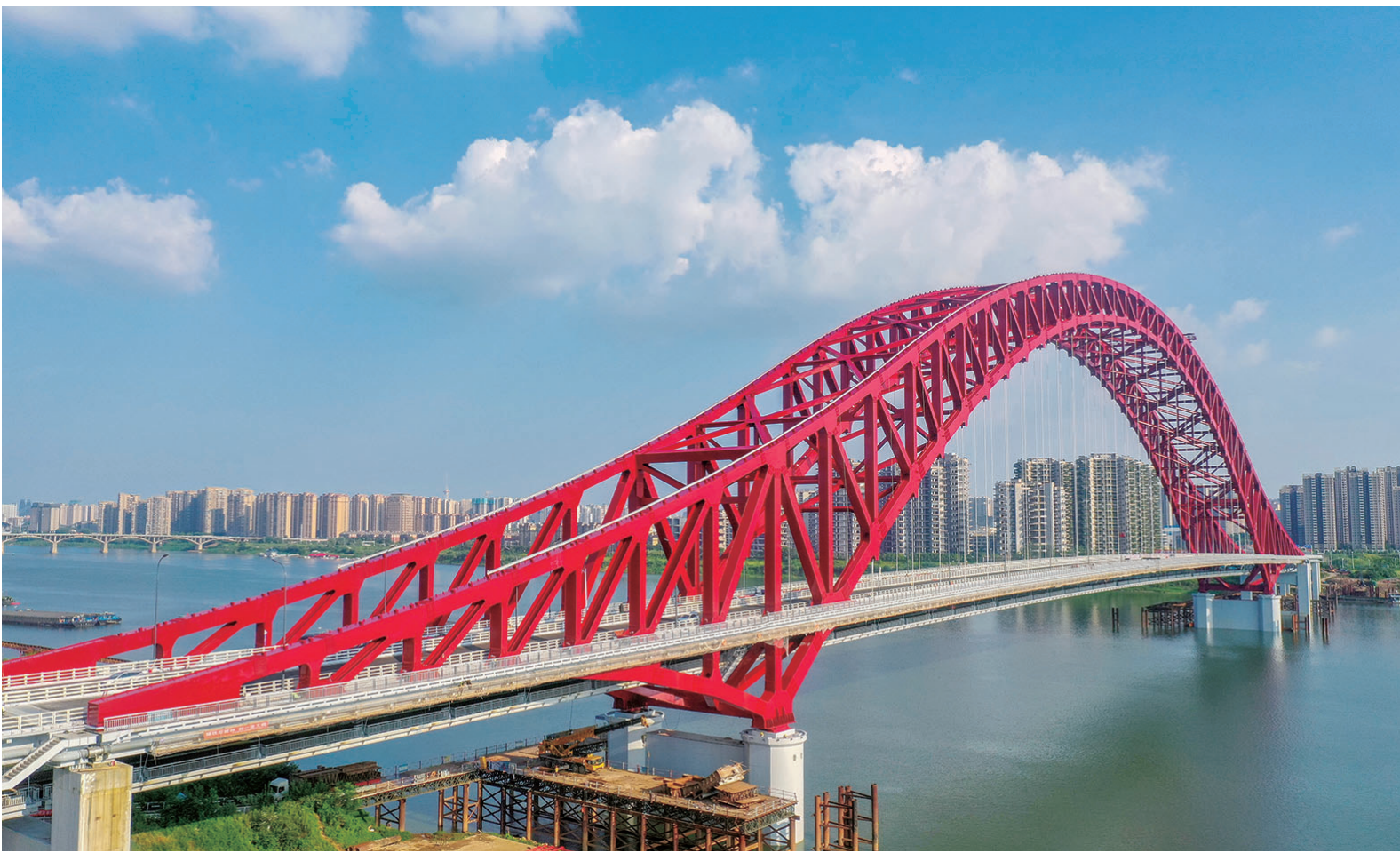
长虹卧波 8月4日，株洲清水塘大桥如一道彩虹横跨湘江之上。目前，该桥建设进入扫尾阶段，正在进行主拱景观亮化、主桥涂装、顶层装饰装修等施工。湖南日报全媒体记者 郭立亮 摄
