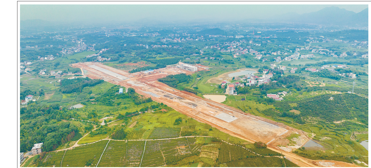
娄底推进通用机场建设 6月12日,娄底桥头河通用机场项目建设现场。该项目位于娄底市涟源市桥头河镇株木村,总投资2.93亿元,占地面积320亩,规划新建1条跑道、1条垂直联络道、地上三层航站楼综合楼及其他机场配套工程,机场建成之后,将有力促进娄底航空产业发展,进一步完善娄底综合交通运输体系建设。 吴永华 摄
