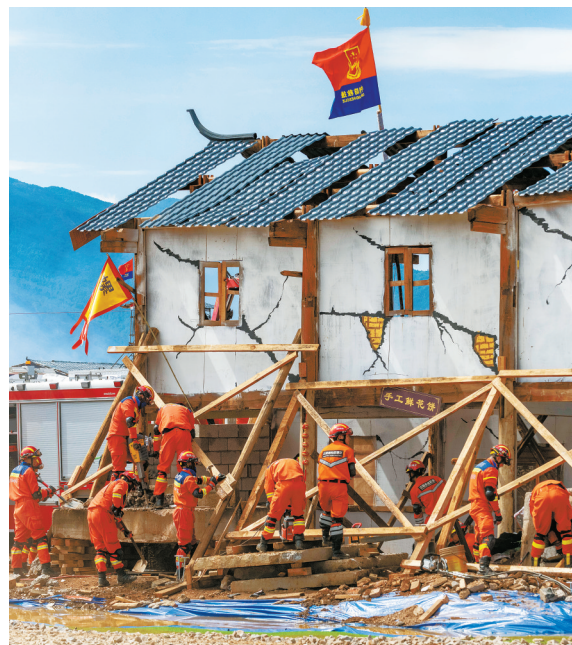
5月16日,云南丽江等地举行高山峡谷地区地震灾害空地一体化联合救援演习,代号“应急使命·2023”。图为当日,参演人员在丽江演习现场对受损建筑物进行排险加固。 新华社发
