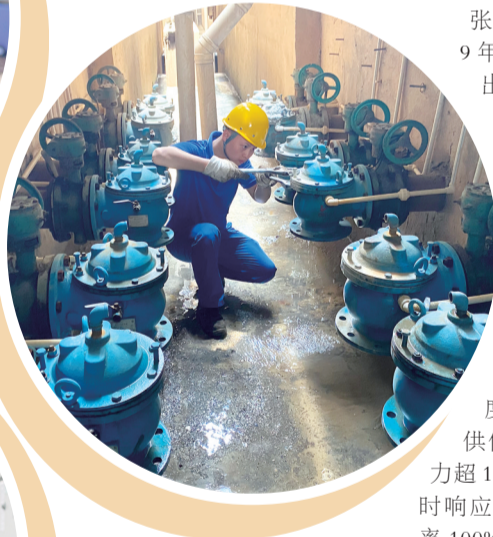
↑南湖水厂肖欣文在现场拆卸阀门。
