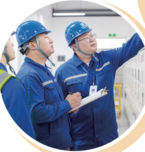
←水厂运行人员在高压配电间巡视抄录生产数据。
