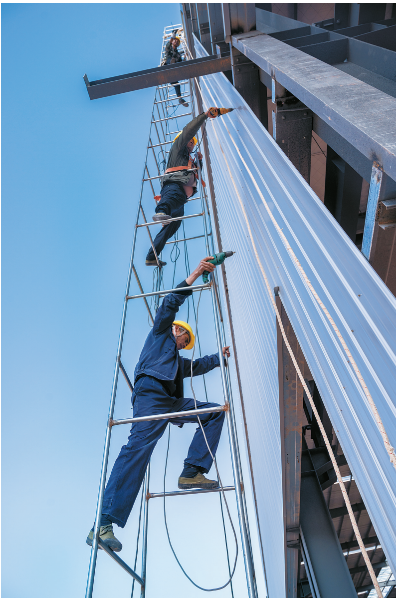
5月1日,娄底经开区内湖南乐立保电气有限公司项目工地,工人正抓紧施工。
