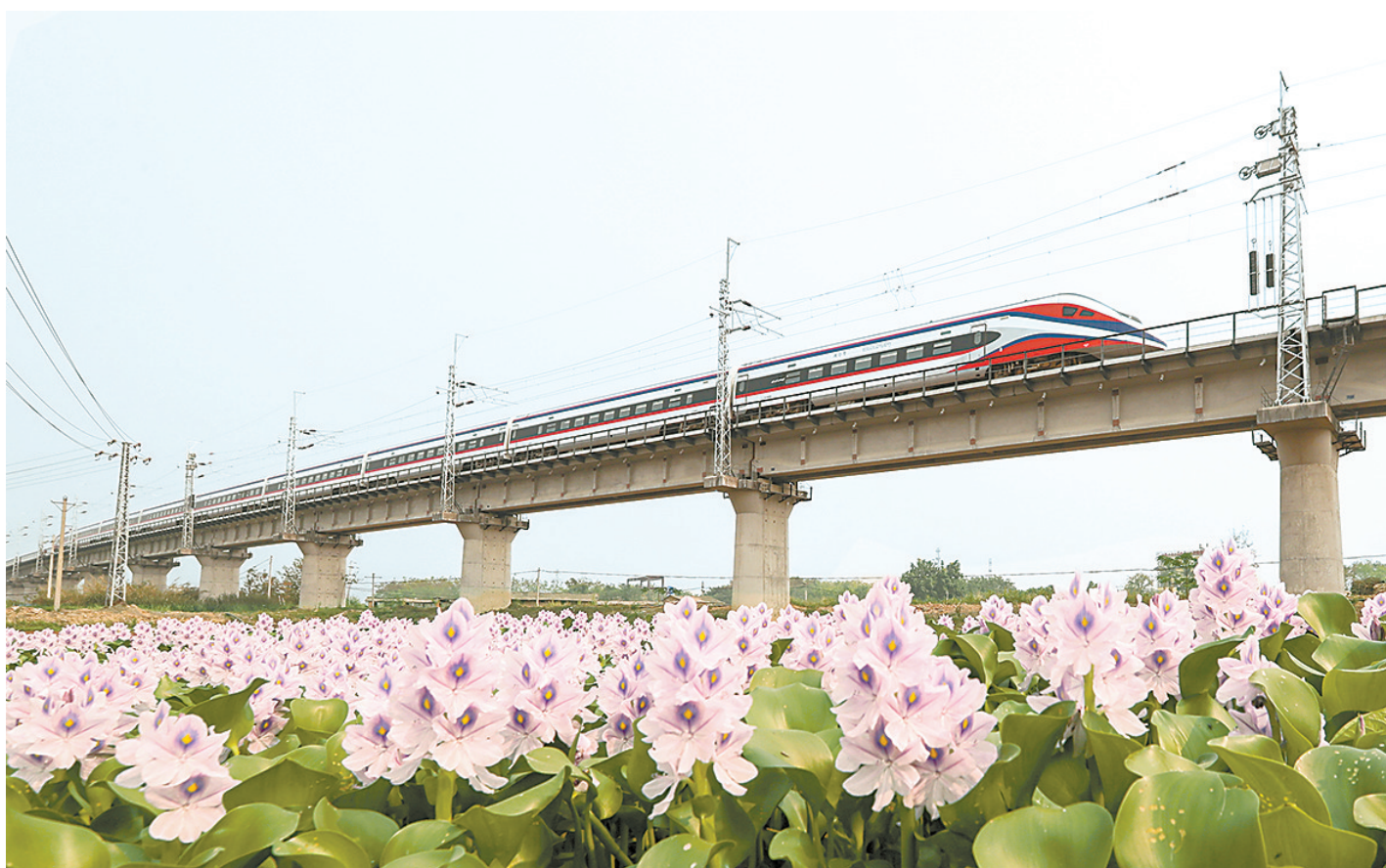
4月13日，从老挝万象站驶出的D888次“澜沧号”列车行驶在云南省西双版纳州境内的中老铁路橄榄坝特大桥上。当日，中老铁路开行国际旅客列车，昆明至万象间可实现乘火车当日通达。
