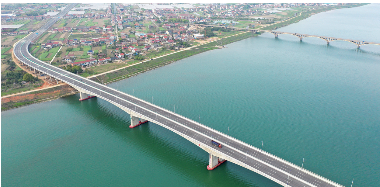
3月31日，常德市沅澧快线1号大道控制性工程澧水张公庙大桥正式通车，全市公路路网结构更加完善。 柏依朴 摄
