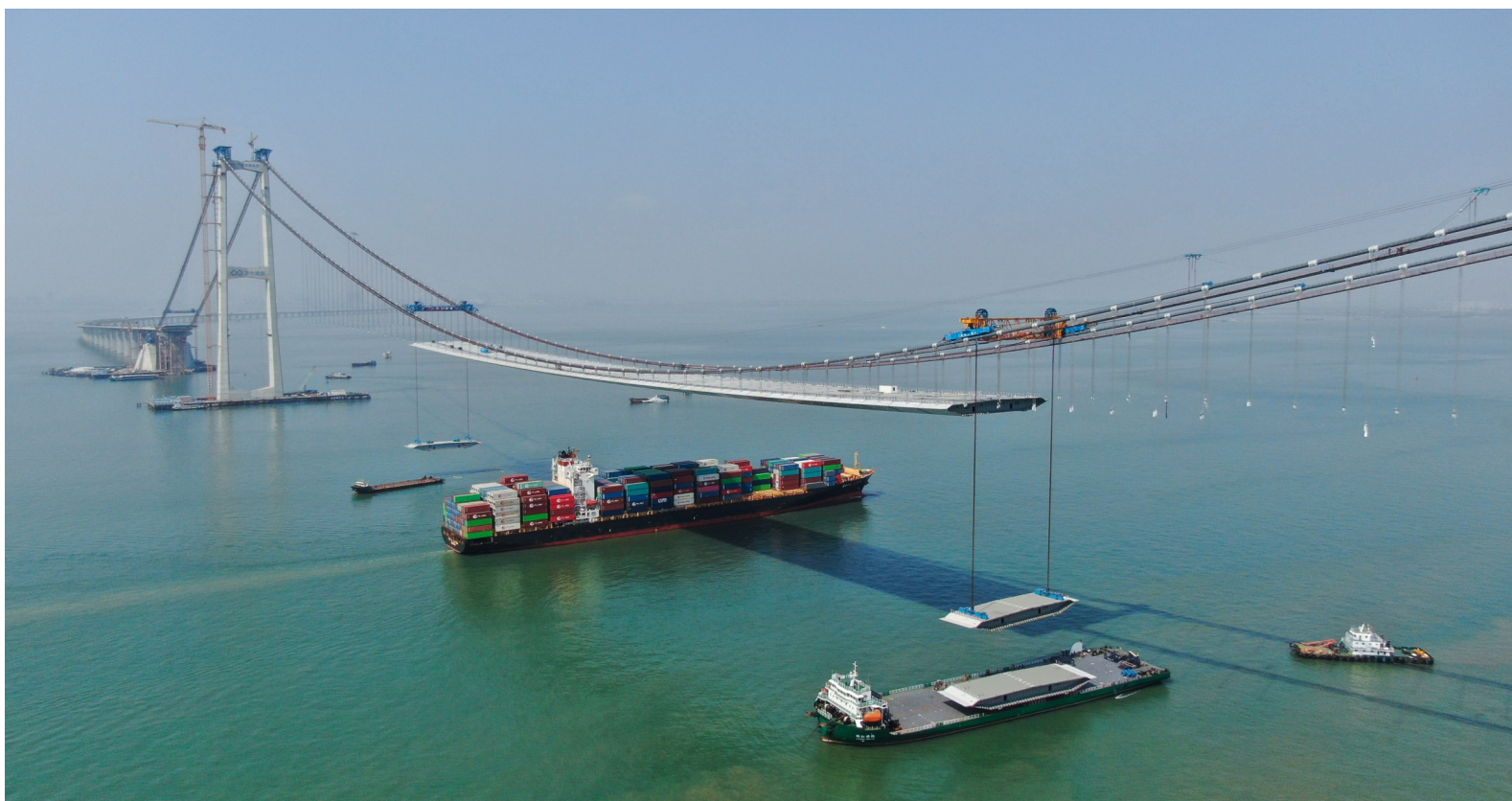
集装箱货轮通过正在吊装钢箱梁的深中通道伶仃洋大桥（2023年2月22日摄，无人机照片）。新华社发
