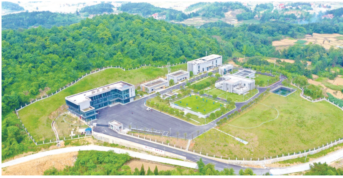
位于稠树塘镇的新建供水工程——武冈市高原水厂。 刘洁 摄
