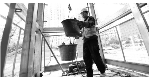
赤岭路街道广厦新村社区新华花园小区正在施工加装电梯。田超摄
