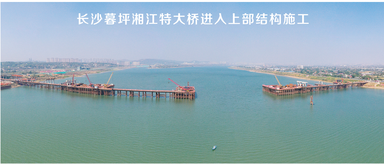
11月1日，建设中的长沙暮坪湘江特大桥。目前，该大桥河西涉水引桥首跨钢梁已顺利顶推完成，标志着正式进入上部结构施工。大桥是促进长株潭一体化发展的省市重点项目，是一条东西向连接长沙南部片区与大王山片区的直达快捷通道，预计2024年建成通车。 湖南日报全媒体记者 郭立亮 摄
