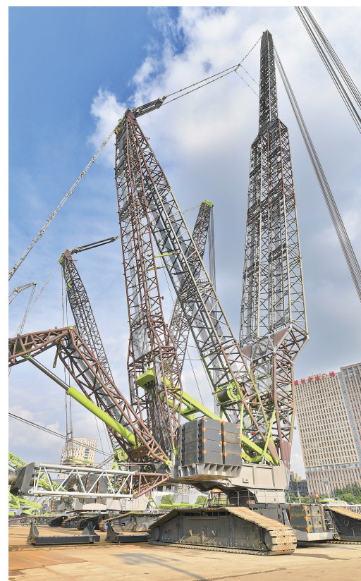
5月26日,中联重科麓谷工业园内的1600吨双履带式起重机。双履带结构可以让这台“巨无霸”在建设场地灵活自如地运行。
