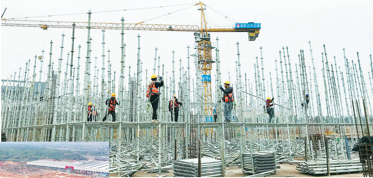
辅助用房框架主体叠扣式脚手架搭设。
