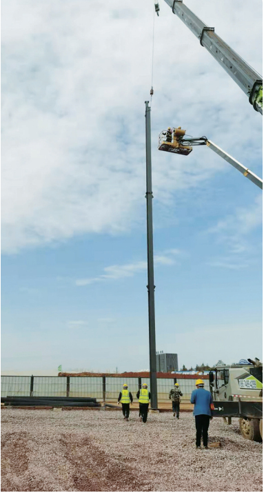
项目现场钢柱整体吊装。
