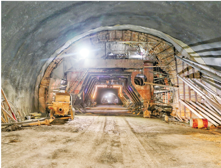
4月29日上午,浏阳金阳大道三期道吾山隧道全线贯通。 刘珂 摄
