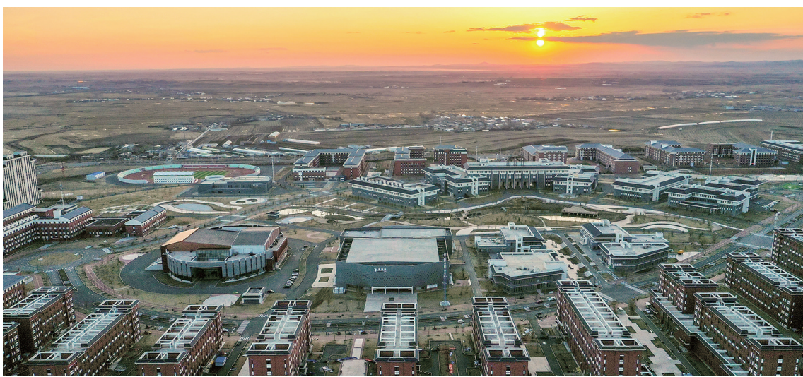
4月12日下午，吉林市第五方舱医院实现清舱（4月12日摄，无人机照片）。
