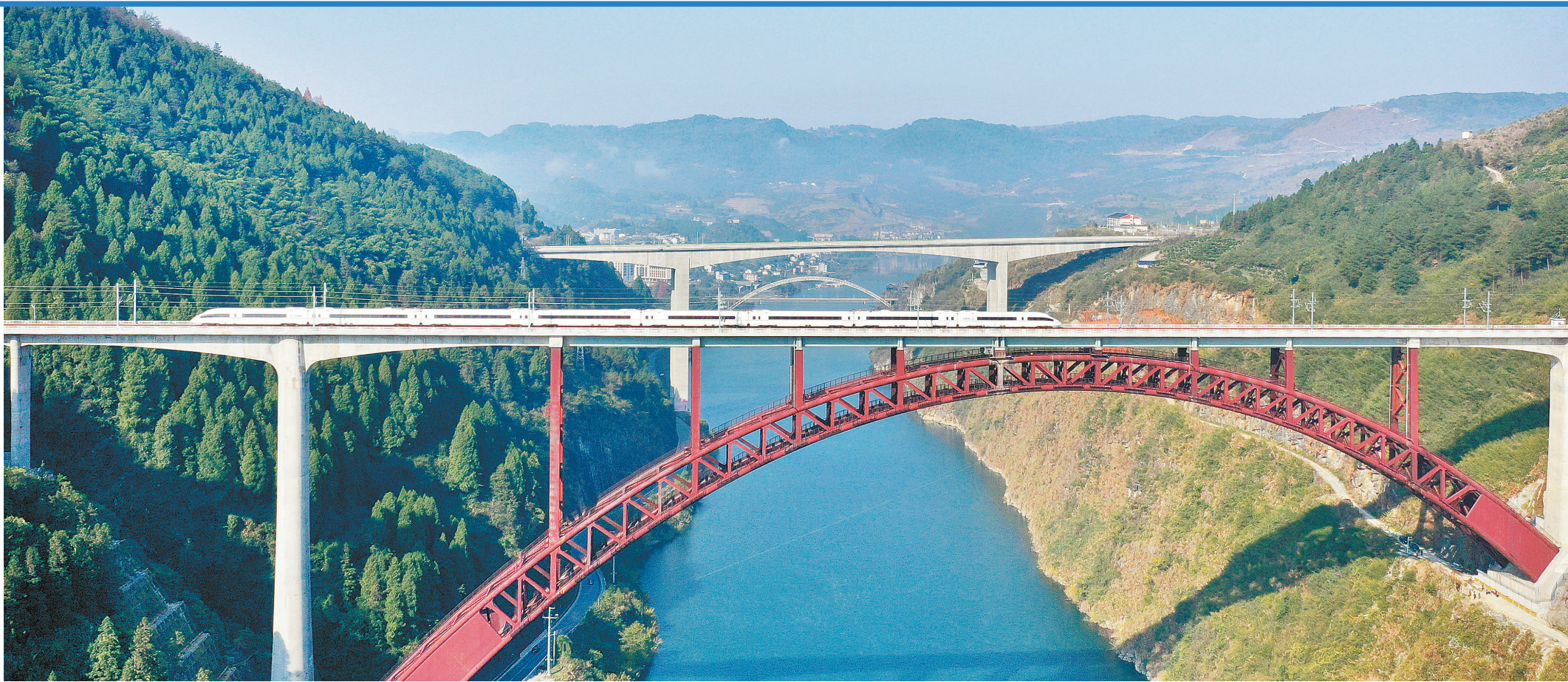
2021年12月6日，一趟“复兴号”动车组列车驶过张吉怀高铁西水特大桥。这条“最美高铁”线路，对改善沿线群众出行条件，推动旅游开发，促进乡村振兴，具有十分重要的意义。湖南日报全媒体首席记者 郭立亮 摄
