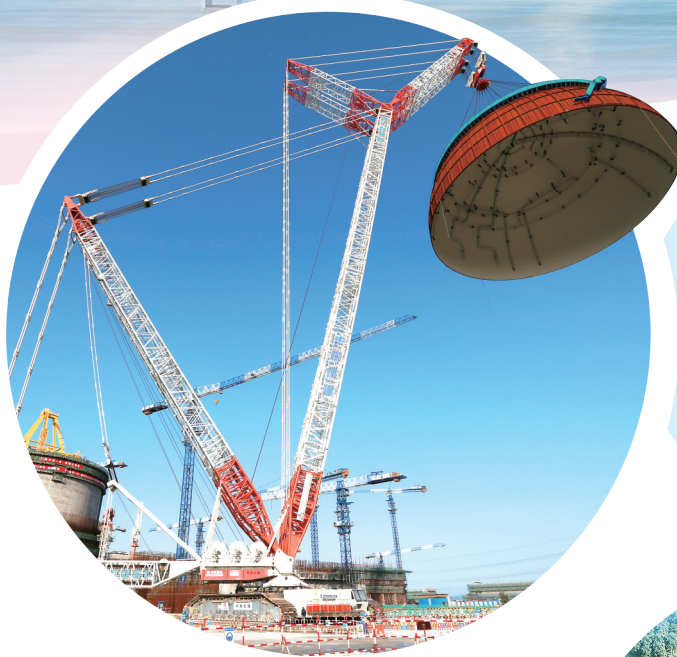
中国首台3200吨履带式起重机助力“华龙一号”穹顶吊装。
