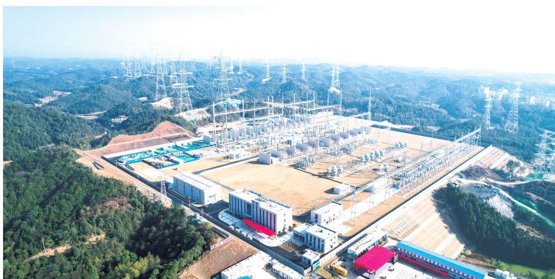
长沙梨梨储能电站全景
