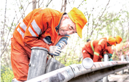
现代投资长沙分公司养护队员在维修钢护栏。
