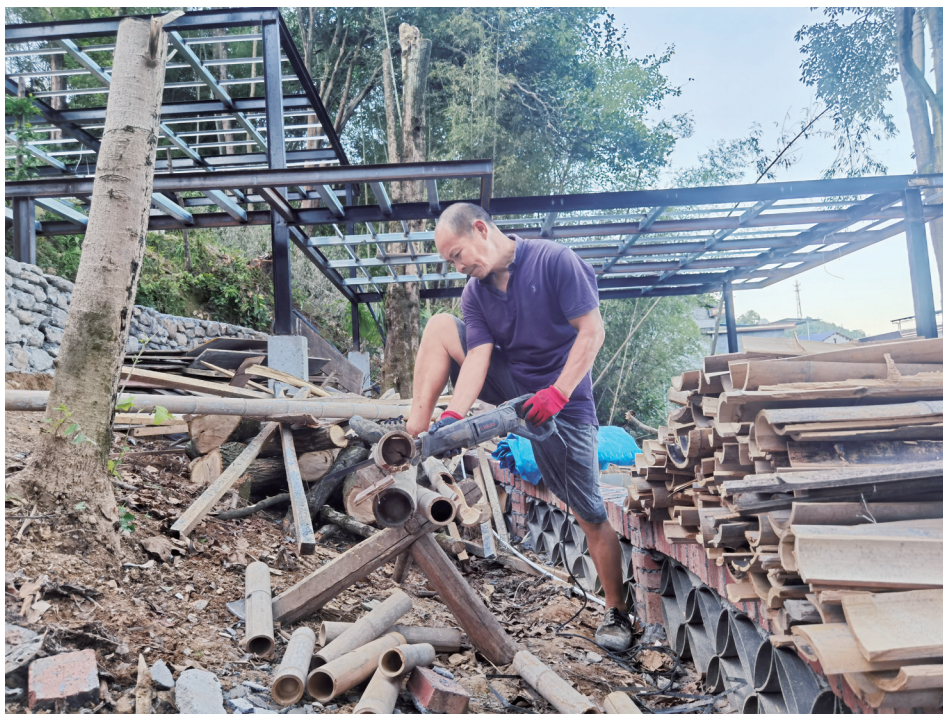
9月29日，廖建民在建设自家小庭院。
