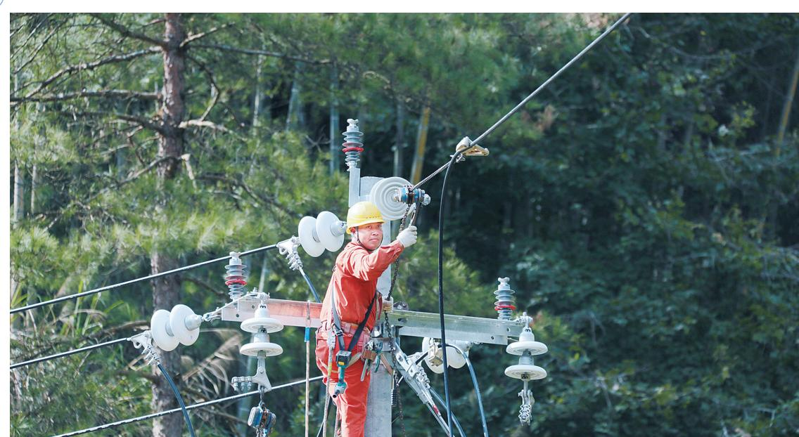
9月15日,桂东县沤江镇三洞村,电力工程队员在电网线上作业。今年,桂东电网全面启动农网线路绝缘化改造工程,计划用2年时间完成全县农网干线10KV绝缘化升级改造,让全县民用上安全、优质电源,助力乡村振兴。邓仁湘 摄
