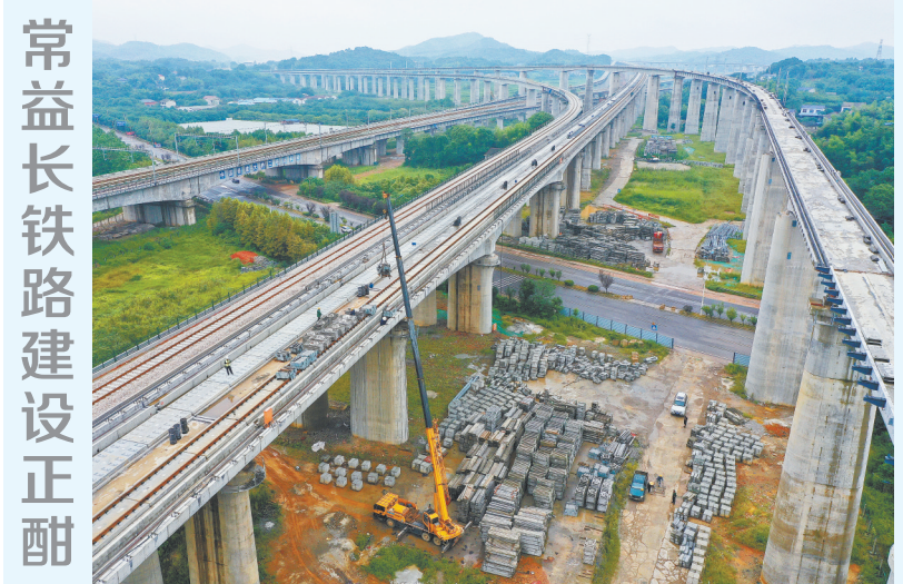
8月27日,位于长沙市望城区的常益长铁路黄桥大道特大桥施工现场,工人在加紧吊装桥面护栏。该桥是常益长铁路全线控制性工程之一,全长3276米,上跨长株潭铁路联络线、黄桥大道等道路。常益长铁路力争2022年底前建成。
