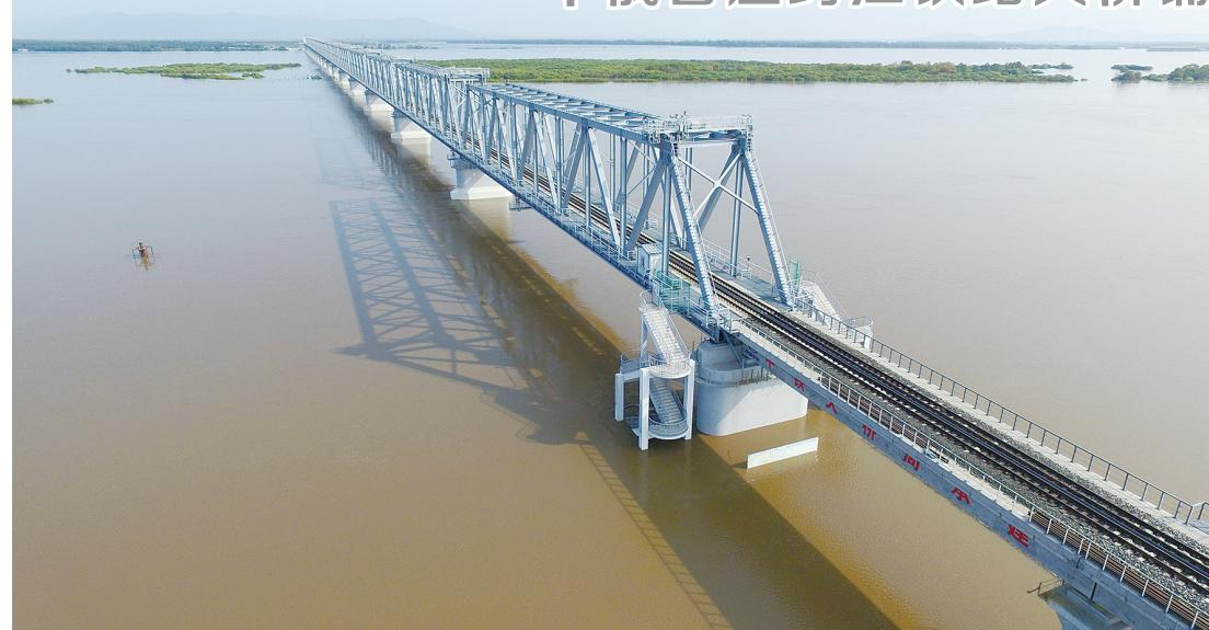
中俄两国首座跨江铁路大桥——同江中俄黑龙江铁路大桥8月17日实现铺轨贯通，该桥位于中国黑龙江省同江市与俄罗斯下列宁斯科耶市之间，设计运营时速100公里、年过货能力2100万吨。图为17日拍摄的同江中俄黑龙江铁路大桥（无人机照片）。
