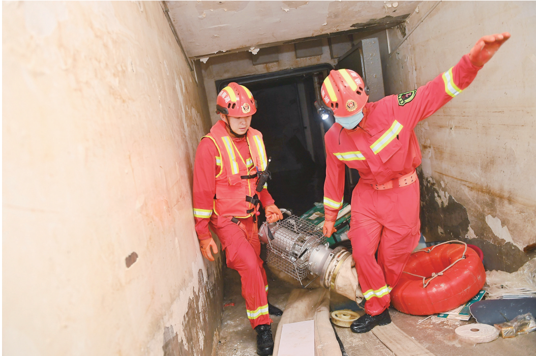
7月24日18时30分,郑州大学第一附属医院地下车库,排涝基本完成后,长沙消防救援总队指战员将设备撤出。
