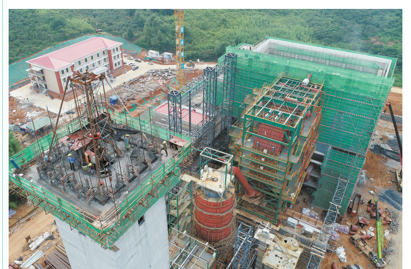
生活垃圾焚烧发电厂建设加速推进 7月17日,双峰县印塘乡,生活垃圾焚烧发电项目建设工地,工人在60米高的烟囱作业平台上作业。该项目总投资2.8亿元,年处理生活垃圾约18.25万吨,年发电量约6090万千瓦时,将于今年11月投入使用。 乃继辉 摄
