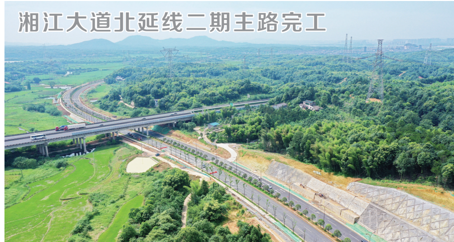
7月6日，长沙市湘江大道北延线二期项目主路建设已完工，达到了通车条件。该项目南起彩陶路，下穿岳临高速，北至城湘大道，全长7.545公里，设计标准为城市主干路。预计9月可实现竣工通车。
