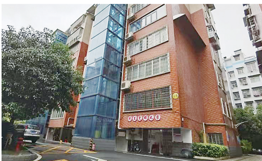
湘潭市高新区三湘鑫苑小区加装的电梯已经投入使用。
