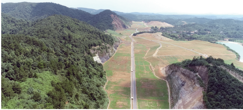
石板滩石煤矿山矿坑整治，让荒山复绿。(本版图片除署名外均由常德市委宣传部提供)
