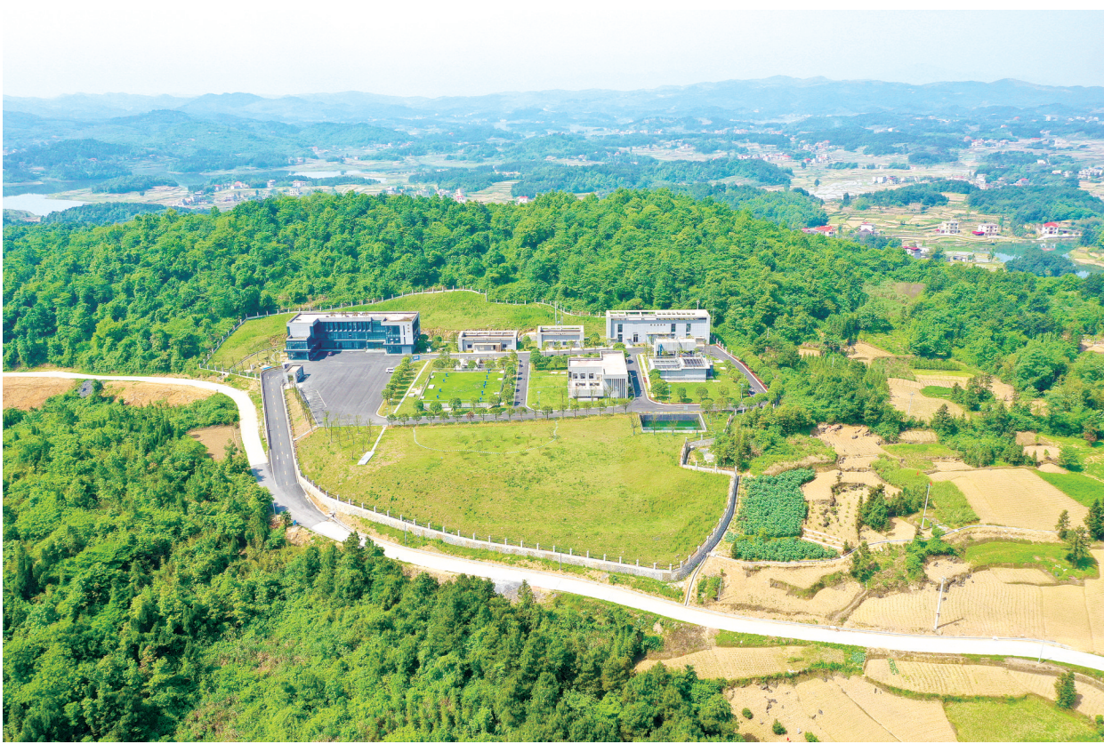
武冈市高原水厂全貌。
