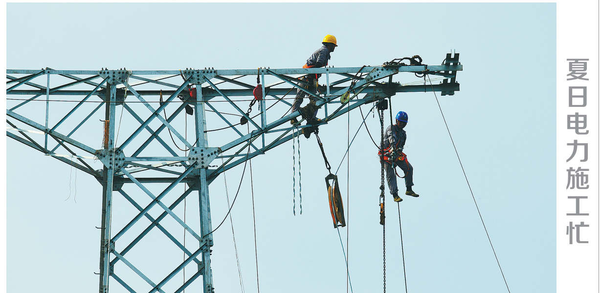
6月20日,嘉禾县晋屏镇南口村,电力工人在永州塔峰—郴州马托220千伏线路项目工地上紧张施工。连日来,国网湖南省送变电工程有限公司电力工人冒酷暑、战高温、加班加点施工,全力推进工程建设。该工程于2019年12月开工,目前进入扫尾阶段,预计今年8月可完工。工程投产后,可每天供电负荷10万千瓦左右,有效缓解当地电力紧缺局面,促进经济建设发展。 黄春涛 摄
