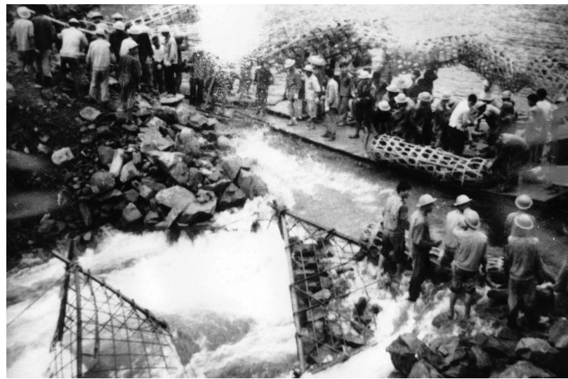
1971年11月，凤滩大坝建设者对西水河进行拦截。(湖南省电力公司档案室供图)
