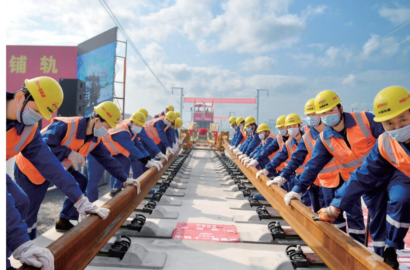
2月1日，在浙江临海，杭绍台铁路工程转入全线铺轨阶段。它连接浙江杭州、绍兴和台州三个设区市，是我国首条民营资本控股的高速铁路项目。
