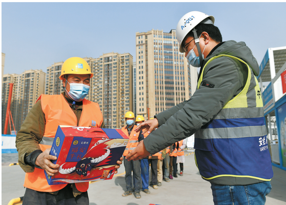
近日，陕西省开展“迎新春送温暖、稳岗留工”专项行动，鼓励农民工就地安心过年。图为1月26日，在西安市东三爻安置小区建设项目，中建三局西坝河公司工作人员向就地过年的工友发放慰问品。新华社发
