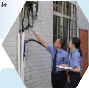
↑衡阳市南岳区人民检察院干警实地查看电缆敷设情况。
