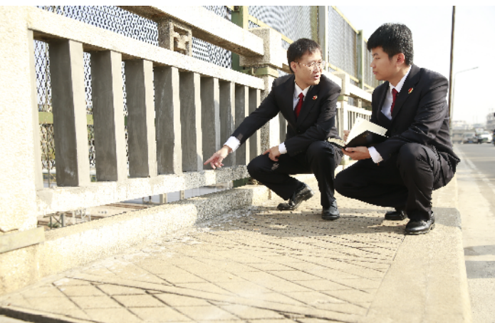
检察干警对光明立交桥人行道护栏及防抛网进行安全检查。
