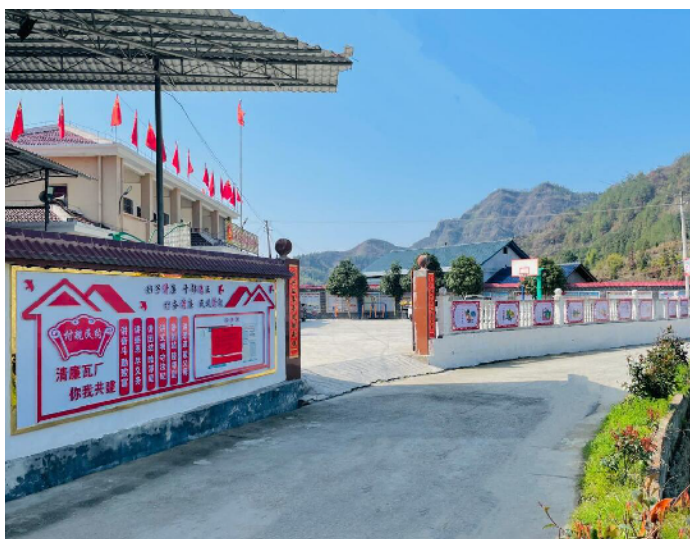
永顺县西歧乡瓦厂村村部建设的文化长廊。
