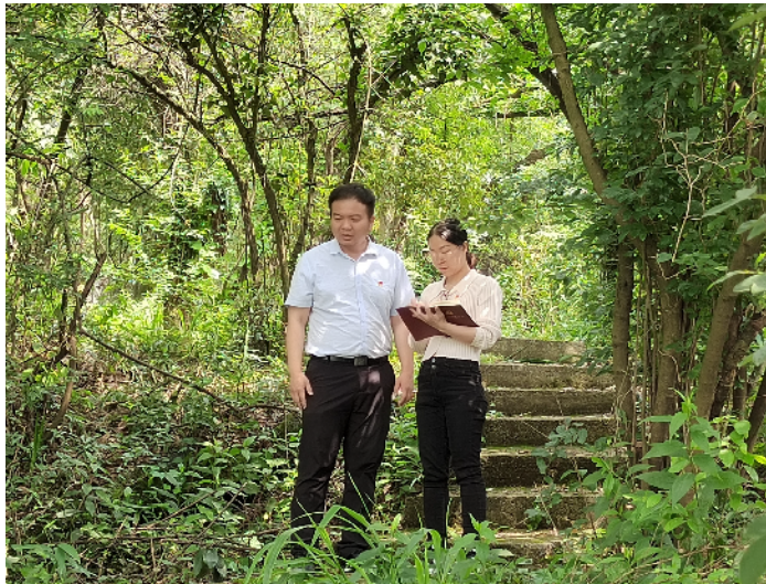
纪检监察干部实地查看金塘岭庄园游道工程。
