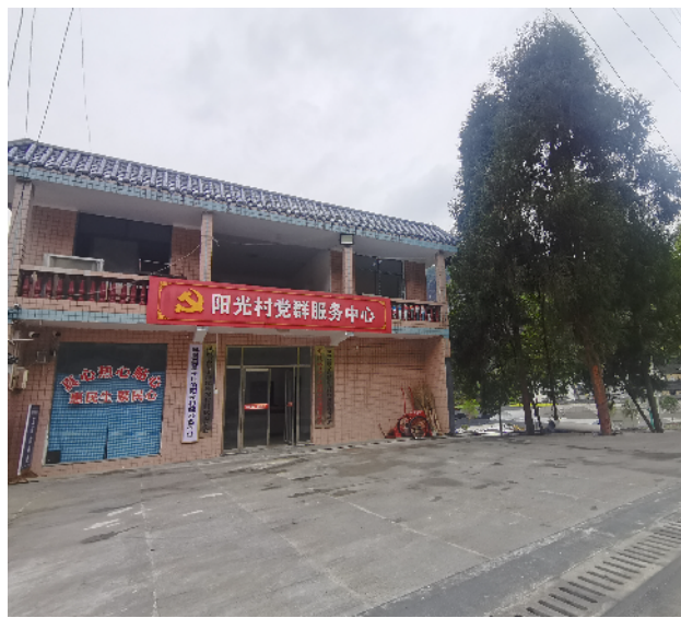
阳光村围墙拆除后,党群服务中心敞亮了。
