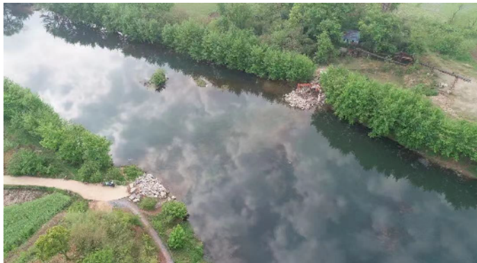
东安县端桥铺镇热兰滩桥拆除后。
