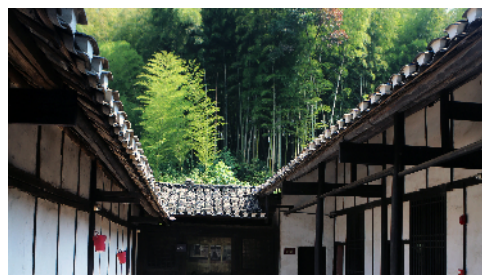
透过周立波故居天井,满眼翠竹婆娑。
