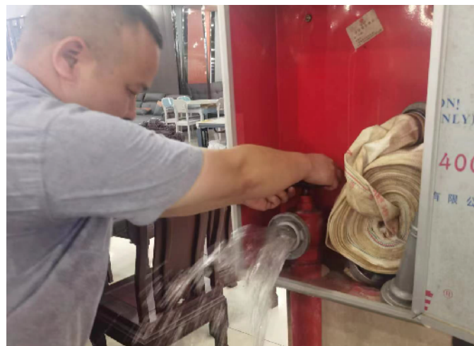
消防执法人员对存在隐患的消防设施进行复查。
