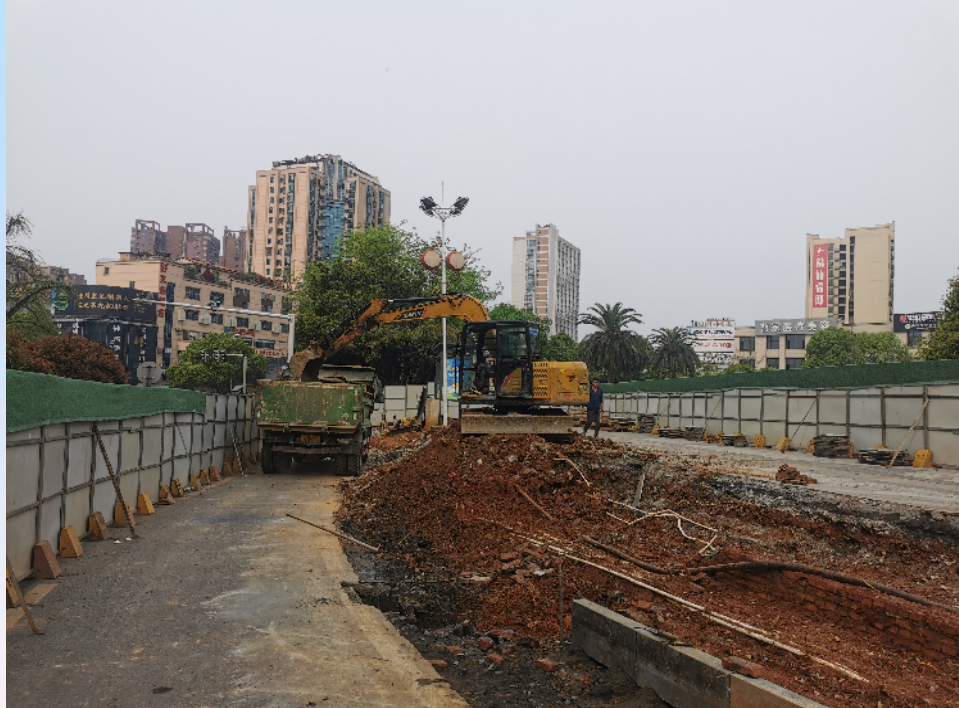
郴州二中校门口道路改造前。
