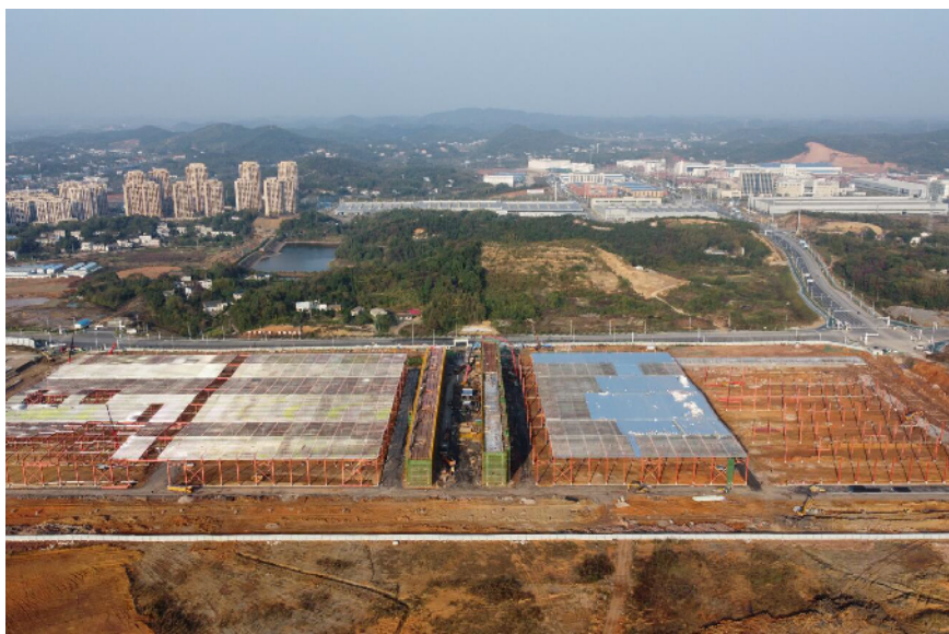
三一智慧钢铁城项目建设如火如荼。
