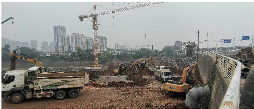
白石港水环境综合治理工程项目正在全力以赴抢进度、赶工期。
