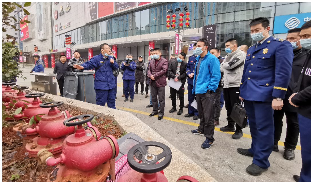
专家对水泵接合器进行教学。
