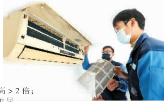
统，防止军团菌滋生在冷却塔或空气处理设备中。确保空气过滤器的清洁和更换。
