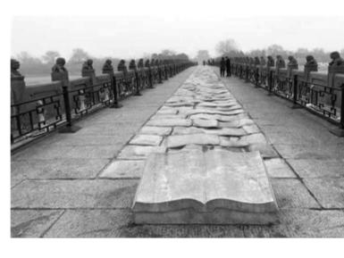
卢沟桥全长 266.5 米,宽 7.5 米,10 个桥墩共 11 个孔。
