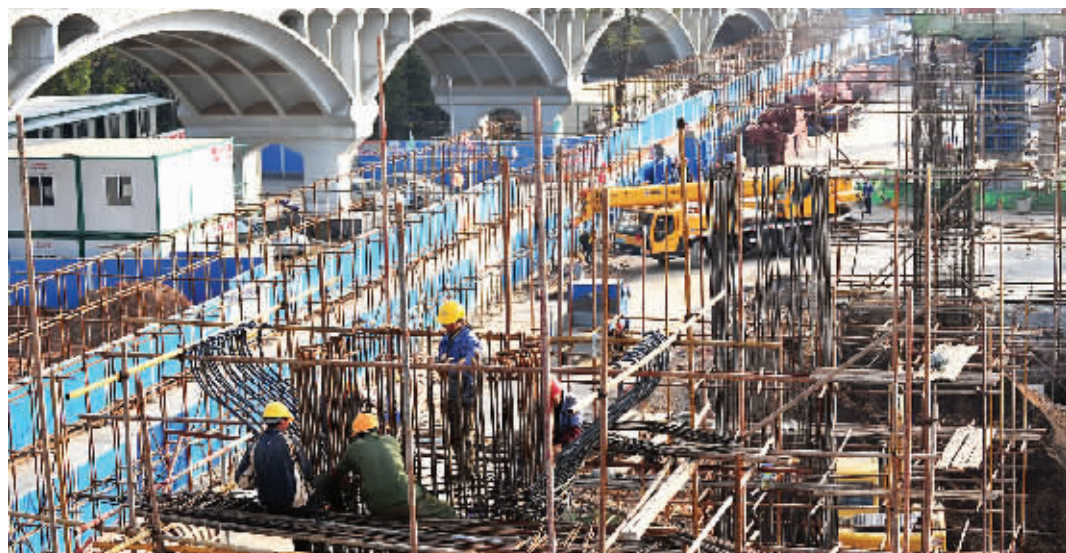
12月7日下午,长沙市橘子洲大桥南引桥西侧,新的南引桥移改工程正按计划进行。记者 田超 实习生 陈杰 摄
