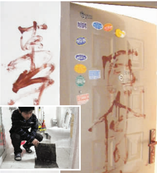
大图:11月2日,长沙市雨花亭非常生活小区。安先生房子的门上被泼上了红色的油漆。 小图:安先生新装修房子出现了许多质量问题。 傅聪 摄
