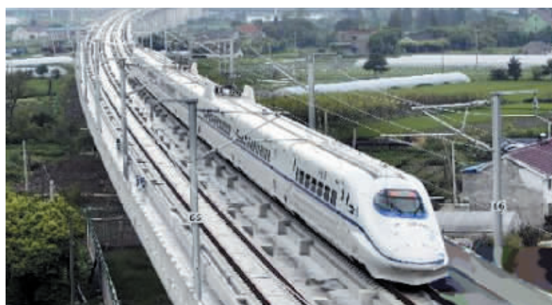
9月1日,沪杭高铁列车在浙江嘉善境内进行调试。当日,沪杭高铁开始进行全线联调联试,调试最高时速达330公里。(资料图片)
